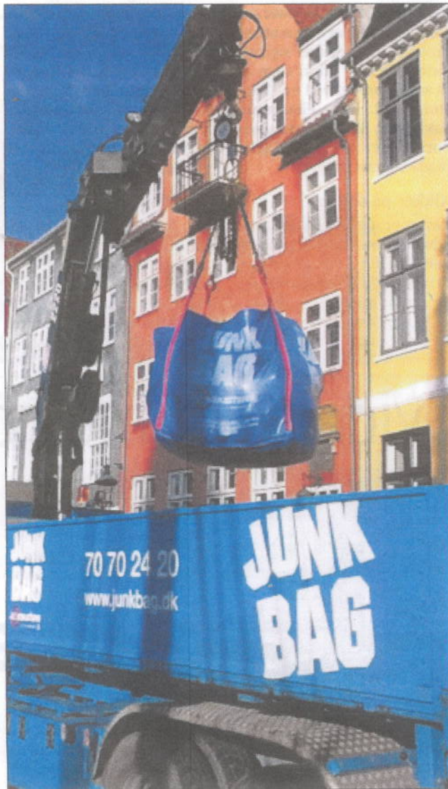
Junk Bag er navnet på et nyt byggeaffaldskoncept, der primært er til mindre byggeopgaver. Her er de i brug ved en renovering på Nyhavn i København.
